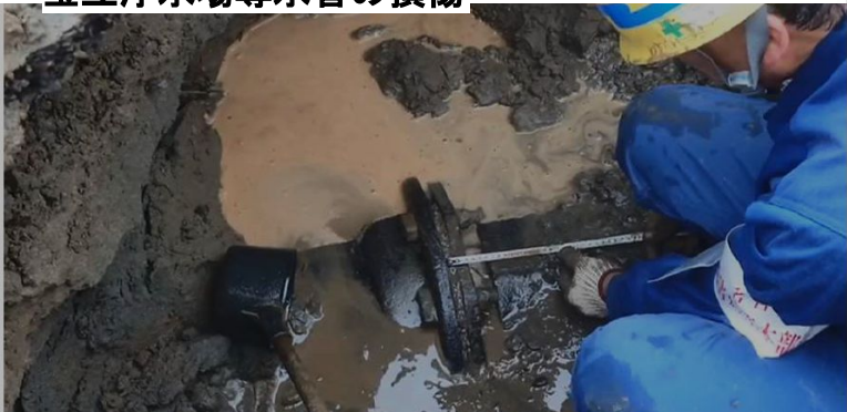
宝立浄水場導水管の損傷
