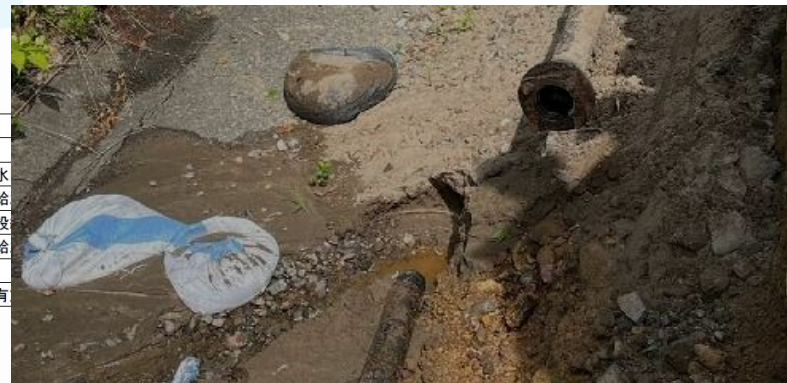
道路(路肩)崩壊に伴う上水道管破断
