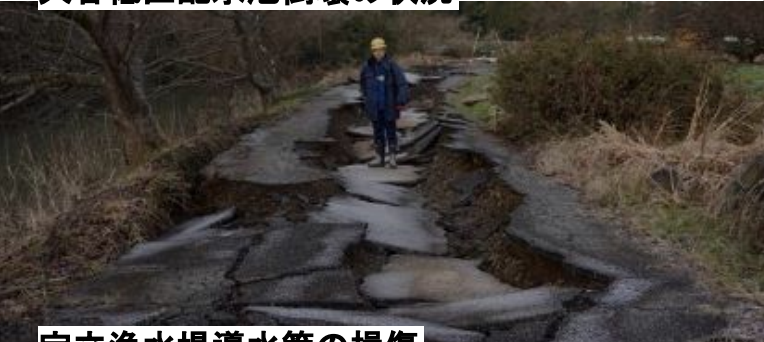
宝立浄水場導水管の損傷
