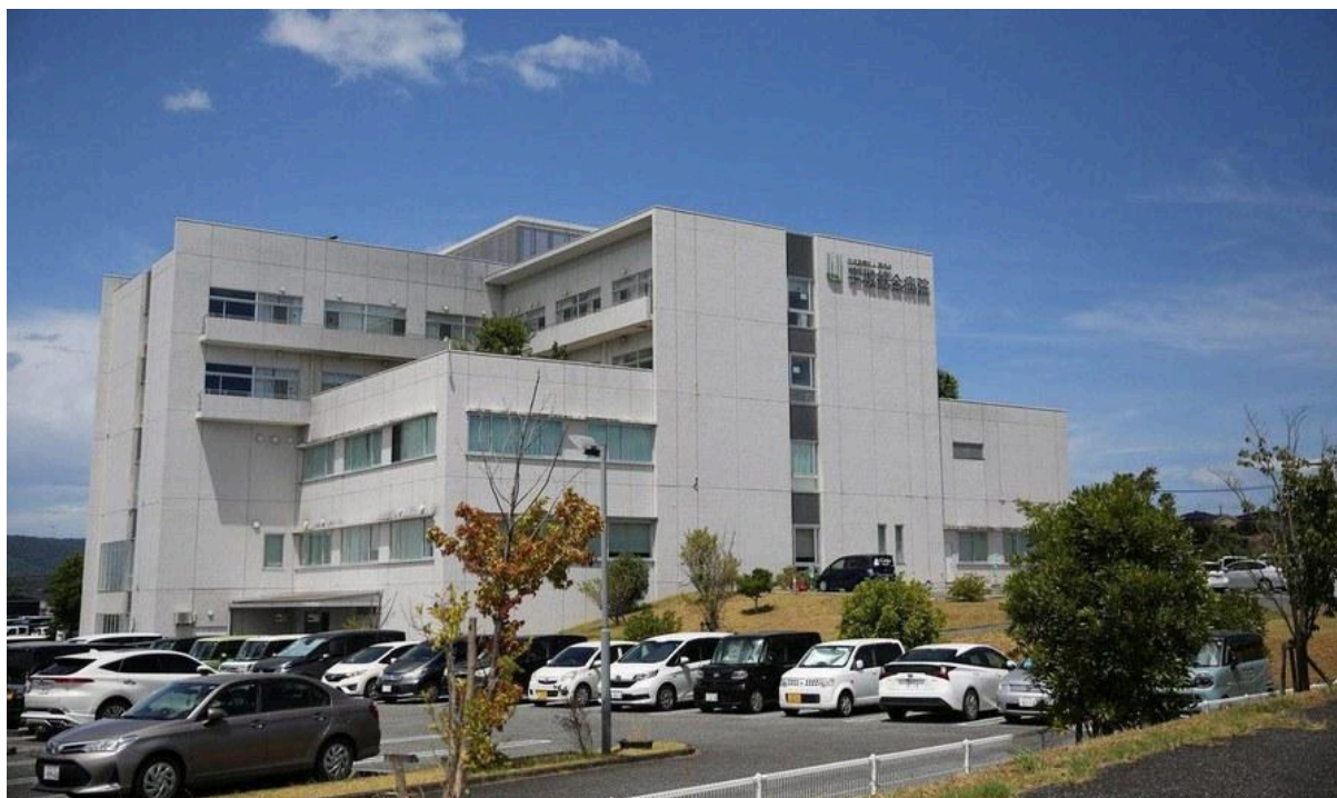
WOTA BOXが設置された宇城総合病院（熊本県宇城市）
